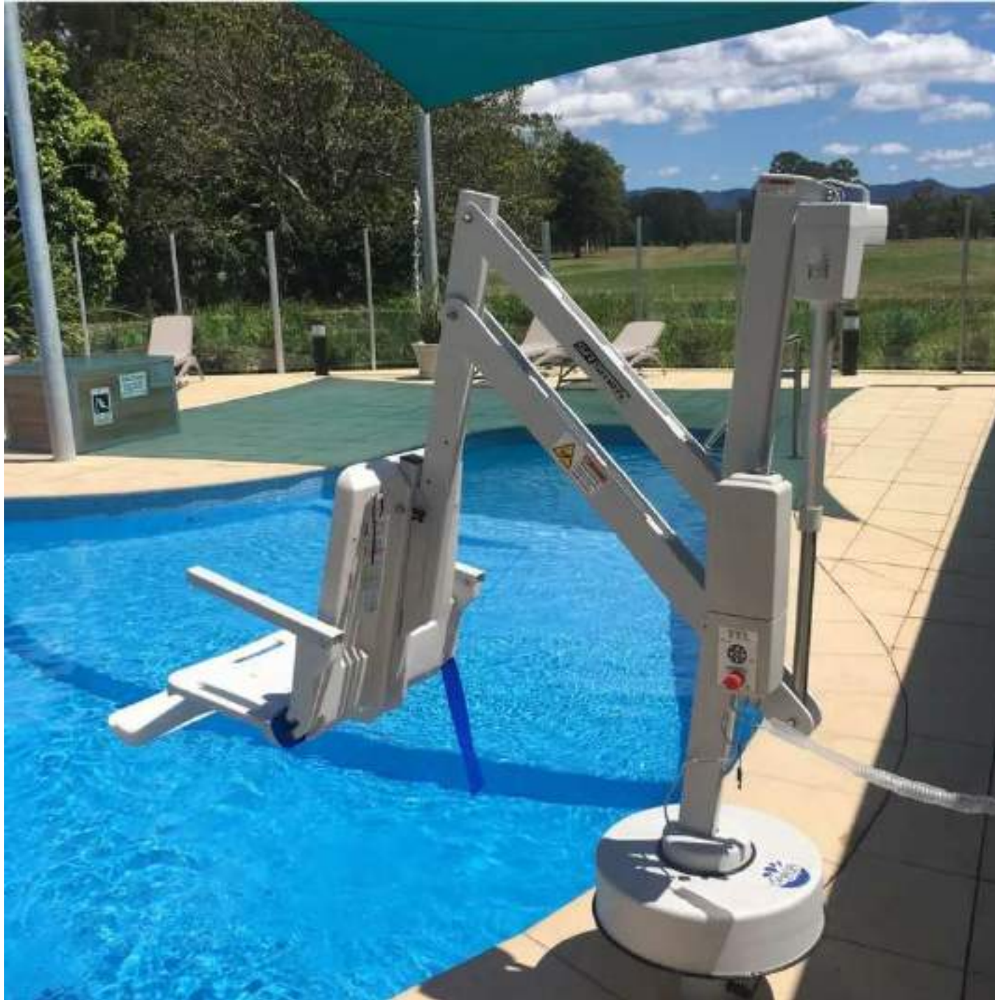
Приклад облаштування спеціального підйомника біля басейну
