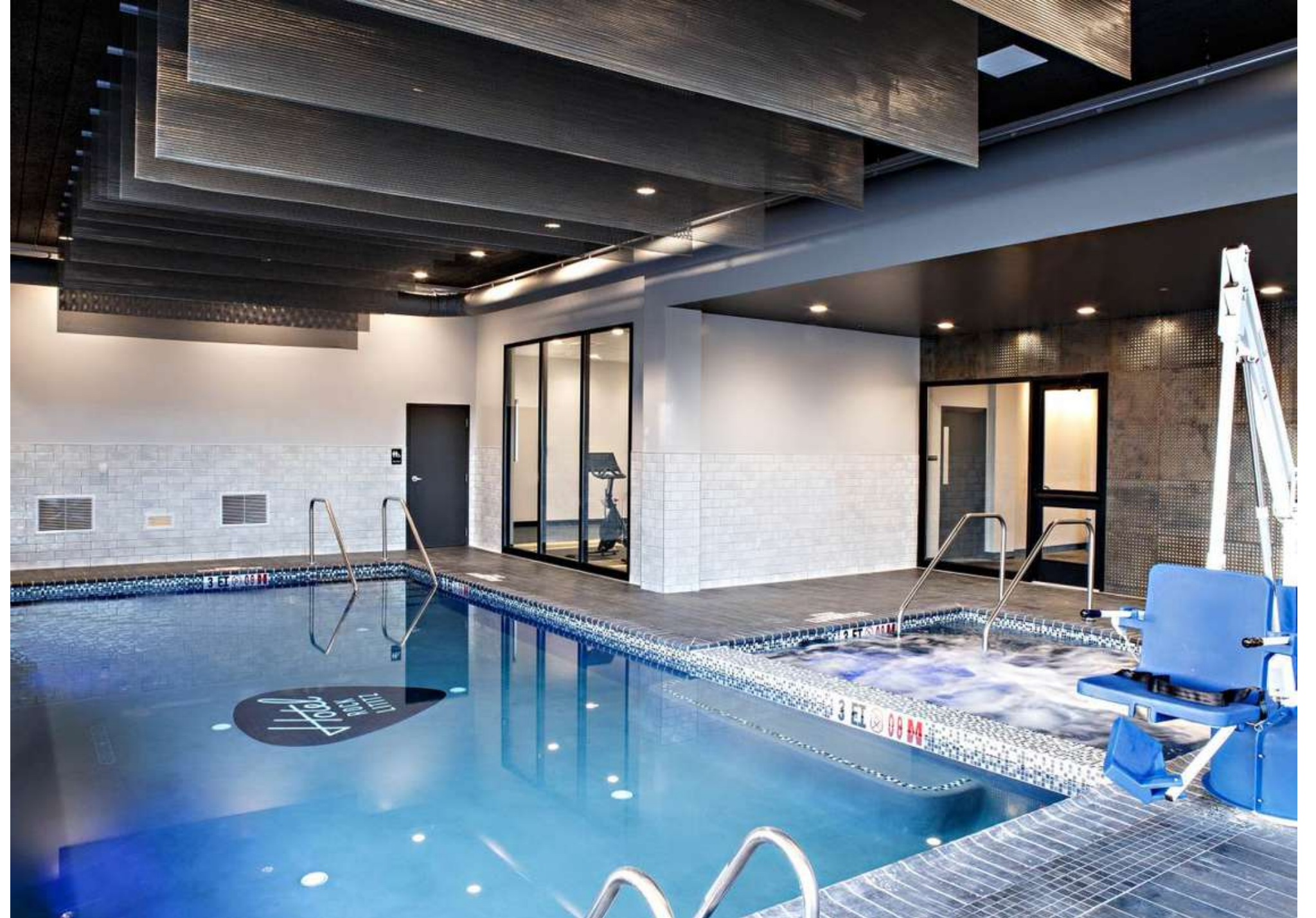
Приклад облаштування спеціального підйомника біля басейну
